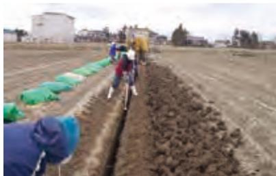
水田における暗渠の整備（幅 15cm、深さ 70cm ほどの溝を掘って地下に排水路を設けます）
